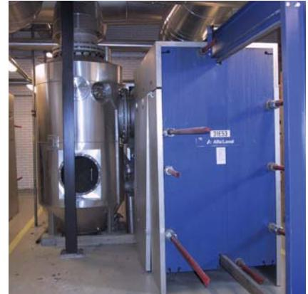
AlfaVap используется в выпарной системе с механической рекомпрессией для упаривания барды на заводе по производству технического этанола.
