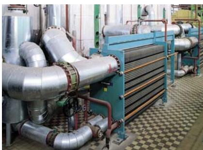
Две системы AlfaVap, установленные в качестве бустера на 2-й и 3-й эффекты выпарной установки сахароррафинадного производства.
