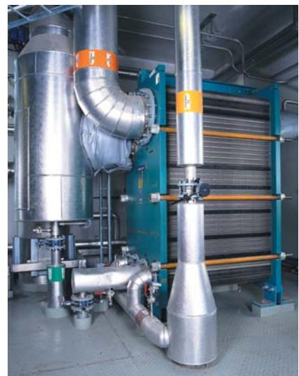
Конденсатор этанола. Компания Absolut (Швеция). Все колонны компании Absolut на дистилляционном заводе в г. Бхус имеют ребойлеры и конденсаторы компании Альфа Лаваль. Аппараты Альфа Лаваль были выбраны в связи с их компактностью.
